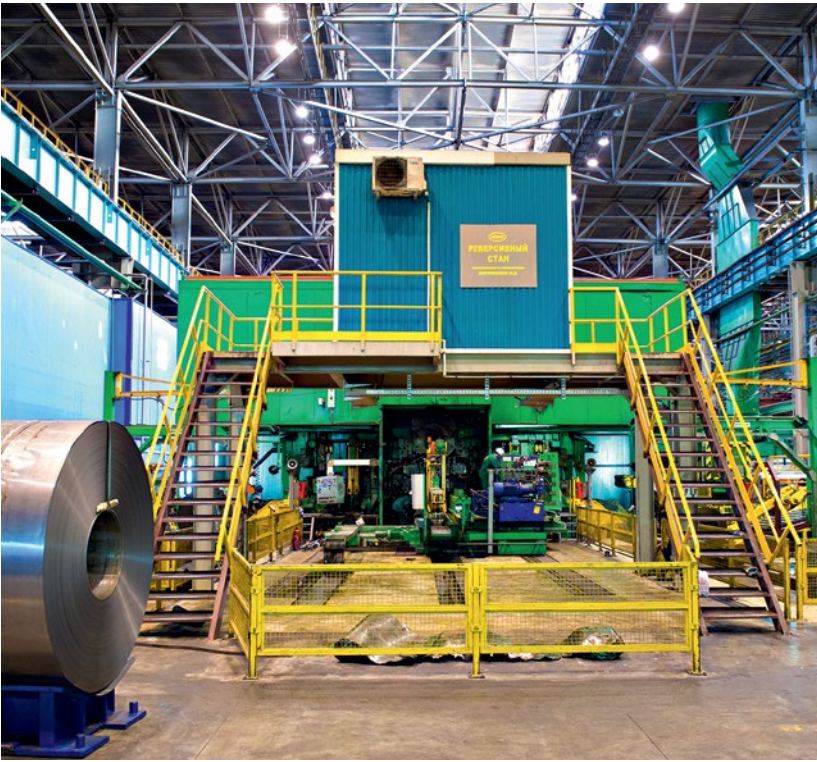
Строительство реверсивного стана
