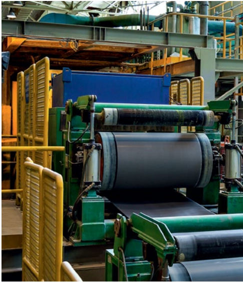
Реконструкция печи непрерывного отжига
